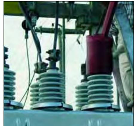
Isolierung mit BCIC-Klapphauben an Seil-Abspannklemmen, um z.B. den Abstand zwischen Isolatorende und Traversenanschluss zu erhöhen
