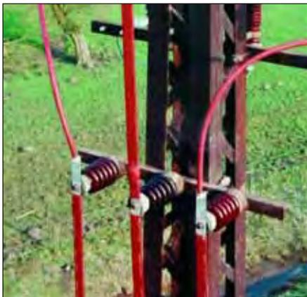
Isolierung der senkrechten Ableitungen an einer Gittermast-Station mit BPTM-Schäuchen
