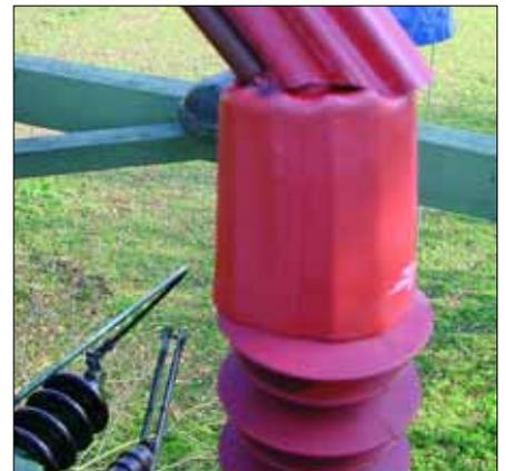
227R077 - Formteil zur Abdeckung am Anschluss des MO-Überspannungsableiters
