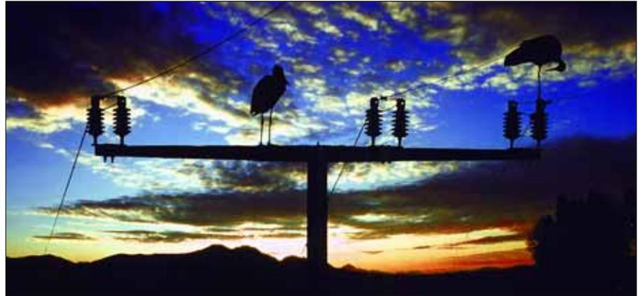
Kurzschlüsse, verursacht durch Vögel, die in Mittelspannungsanlagen eindringen, sind eine zwar seltene, aber ernst zu nehmende Gefahr für die Stromversorgung.
