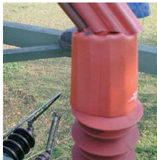
227R077 – Formteil zur Abdeckung am Anschluss des MO-Überspannungsableiters
