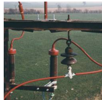
208R066 – Formteil zur Abdeckung an einem Ventilableiter, Haube nach unten offen
