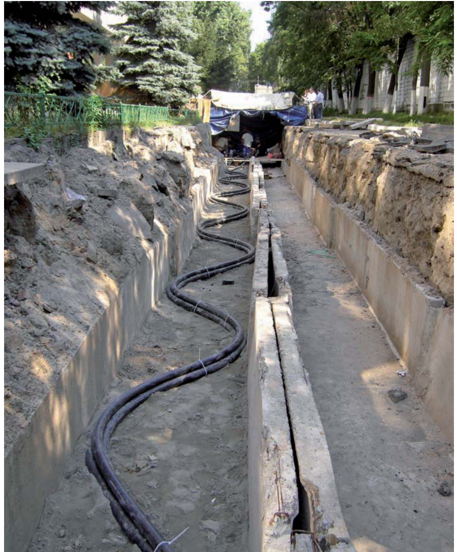
Kabelverlegung und Verbindung in einem Betonkabelkanal.
